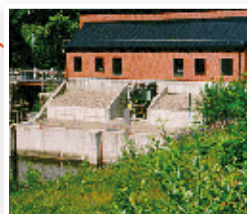
Ålsätra Byggses 1986 1,4 MW effekt
