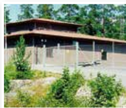
Hallstahammar Byggses 1997 15 MW effekt
