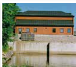
Seglingsberg Byggses 1986 1,5 MW effekt
