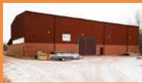
KANALBYGGNADSHYTAN Hans von Kantzows v 25, Hallstahammar 070-378 11 21 www.stromsholmskanal.se
